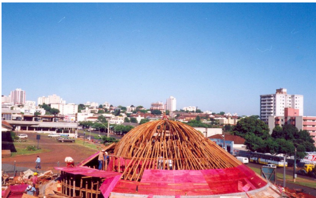
Figura 1 - Construção da cúpula do planetário, em 1991. Fonte: acervo particular de Rute Helena Trevisan.
